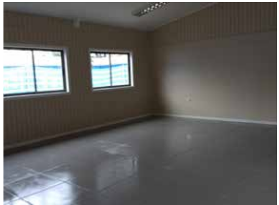
Construcción sede social
