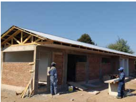
Construcción camarines sector sur
