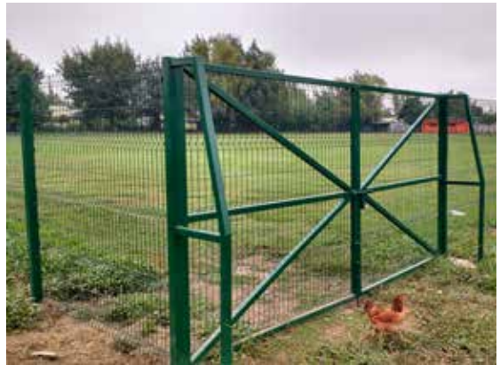
Cierre perimetral cancha Corralones
