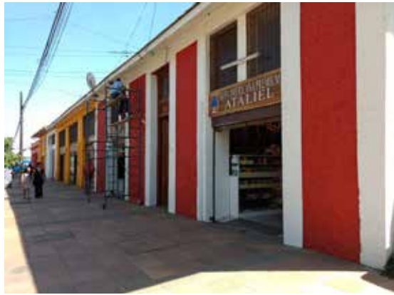
Fachadas Barrios Comerciales
