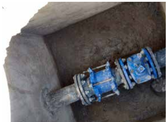
Extensión agua potable Palo Seco
