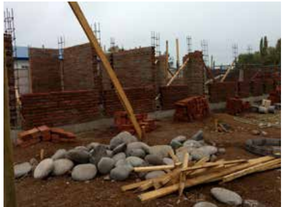
Construcción estación médica Flor del Llano
